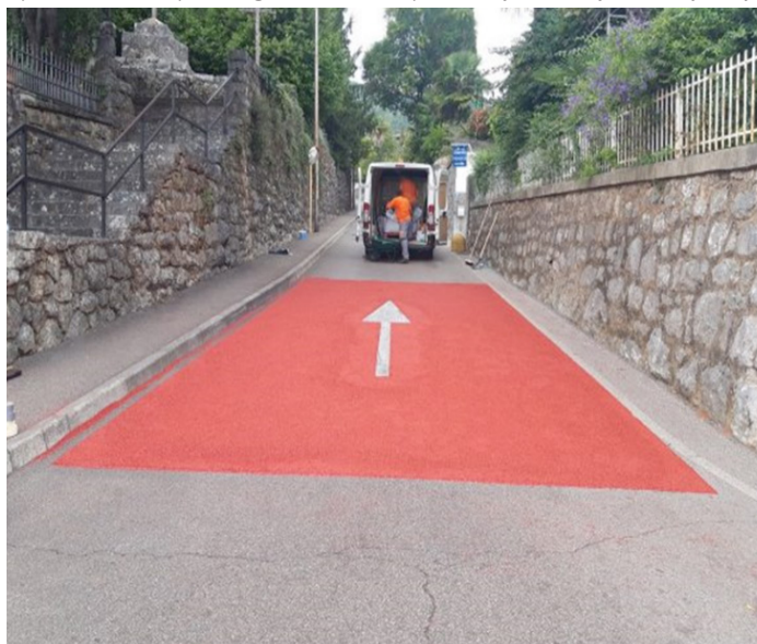
Primjer postavljanja protuklizne podloge u Lovranu
